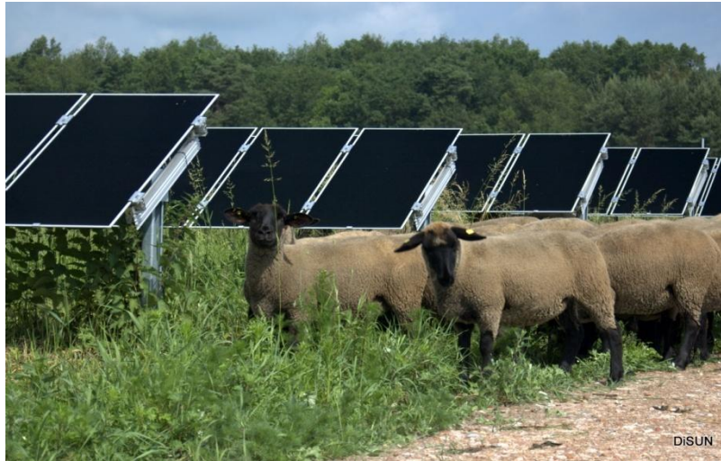
Abb. 31: Höhe der Schafe im Vergleich zu Modulen, die zu Bruch gingen (Foto: DiSUN Management & Service GmbH)
