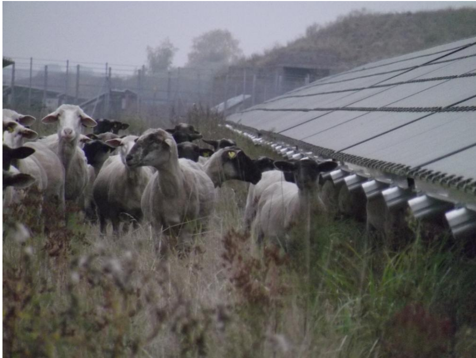
Abb. 34: Bei stabil aufgehängten Dünnschichtmodulen sind auch bei geringer Höhe der Unterkante kaum Schäden durch die Schafe zu erwarten.
