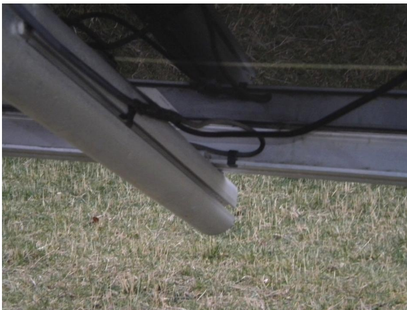
Abb. 25: Befestigung der Verkabelung mit Clips
