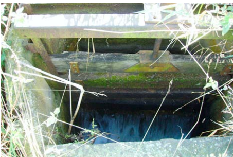
Abb. 3: Altes, funktionsloses Wehr in einem Entwässerungsgraben der Belziger Landschaftswiesen (Foto: E. Wallor)
